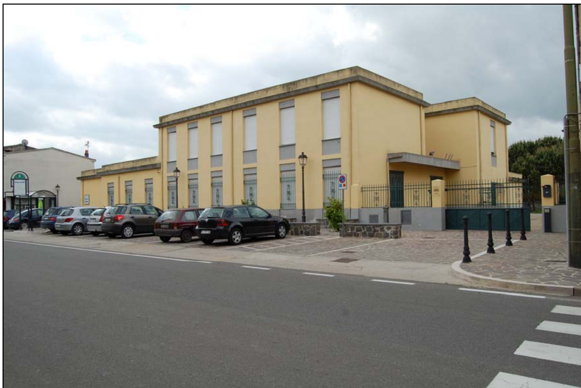
AT. 07 Piazzale del centro sociale
