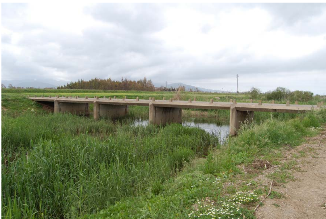
Vista di ponte sul Flumini Mannu (indicato con il n° 2 nella Tav. 9)
